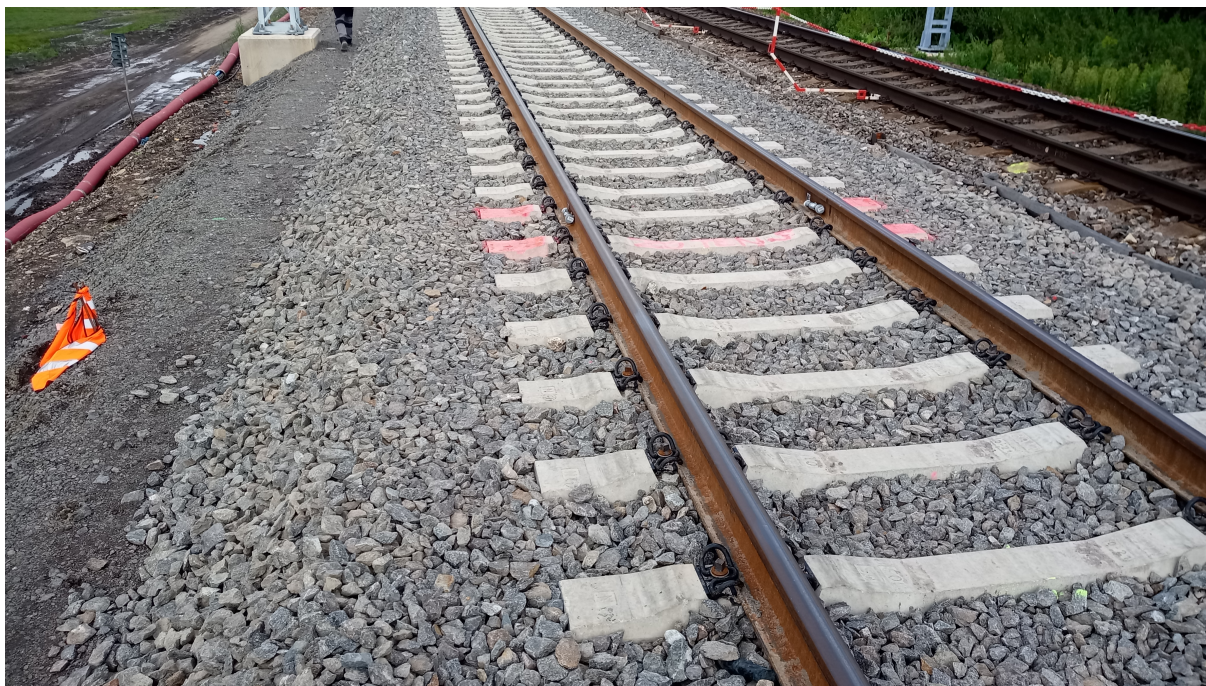
Obrázek 9 – Označení staničení s měřicími body v lokalitě Bezpráví červenou barvou na horních plochách pražců vně kolejového kanálu a zároveň vlajkou utvořenou z oranžové reflexní vesty.
